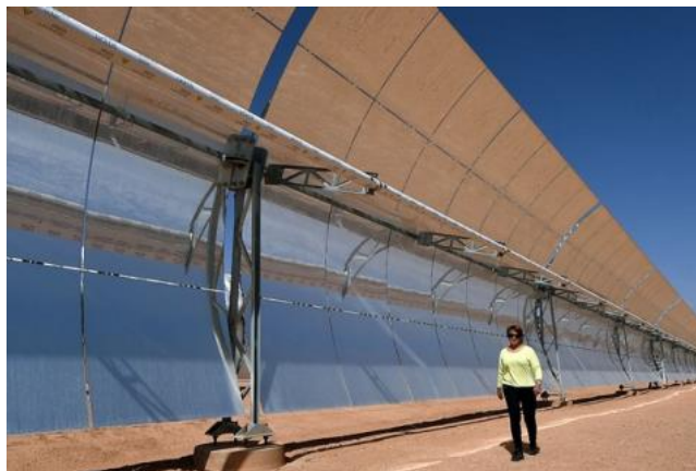
Рис. 1 – Дзеркальні відбивачі параболічної форми
